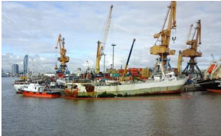
Puerto de Montevideo Noviembre 2015
